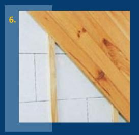
• Ecartés entre eux de plus ou moins 40 cm, les tasseaux sont placés horizontalement pour une pose verticale (4) et verticalement pour une pose horizontale (5). Une pose oblique peut se faire sur tasseaux horizontaux ou verticaux (6). Des tasseaux doivent être placés en périphérie de la surface à décorer et des portes et fenêtres.
