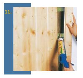
Dans certains cas ou pour la dernière lame, la fixation est possible au moyen de colle de montage (11). Certains produits épais bruts de sciage nécessitent une fixation par pointes têtes d'homme (50 mm minimum), en biais dans les rainures ou les languettes. Utiliser un chasse clou pour rendre la
